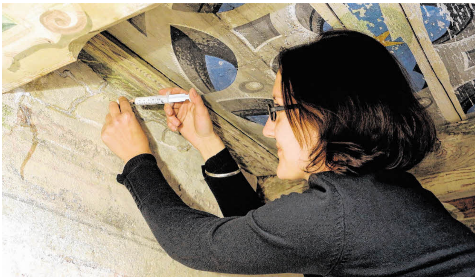
Christine Pieper verfestigt mit gezielten Injektionen den instabilen Wandputz zwischen den Deckenbalken im ersten der drei Prettiner Frauengemächer. Sie will damit unbedingt verhindern, dass er sich ablöst, was den Totalverluste von Teilen der Wandbemalung zur Folge hätte.
