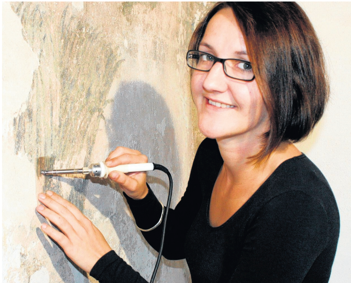
Mit Leim-Spritze und Heizspatel (im Bild) fixiert Diplom-Restauratorin Christine Pieper aus Leipzig Zentimeter für Zentimeter die in Ablösung begriffenen Farbschuppen der Wandmalerei im Raum I der Frauengemächer. FOTOS: D. MAYER
