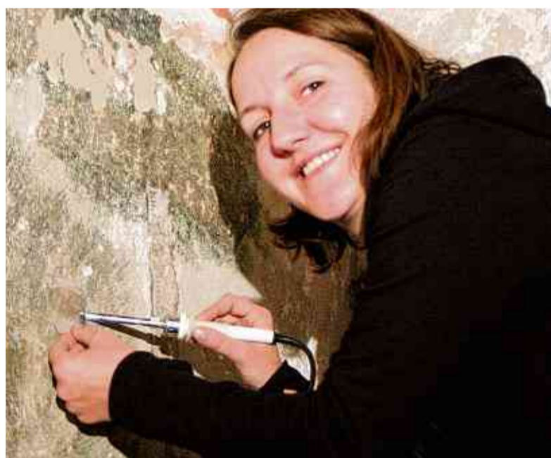
Christine Pieper arbeitet an der Wand im Raum I der Frauengemächer.
