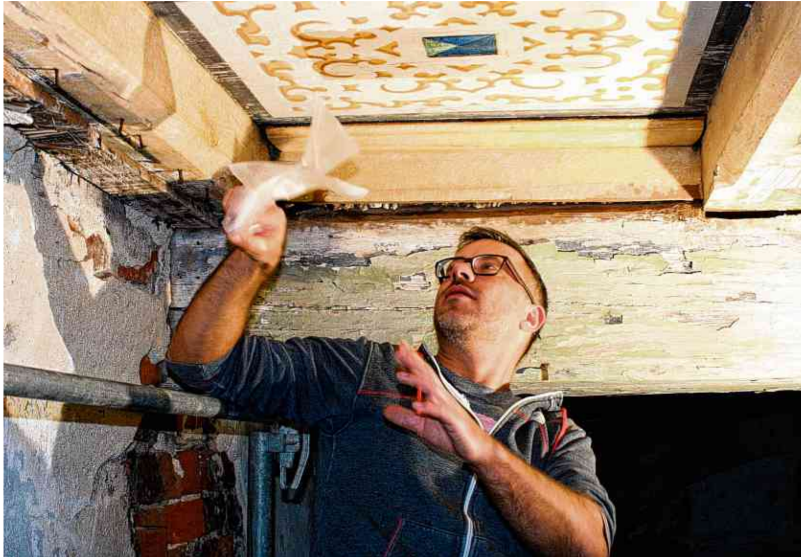
Tino Simon reinigt und konserviert die Deckenmalerei aus der Bauzeit des Prettiner Schlosses um 1580 im nördlichsten Raum der Frauengemächer. FOTOS: D. MAYER
